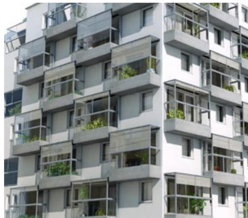
Fassadendetails: Loggien mit vorgelagerten Pflanzbereichen
