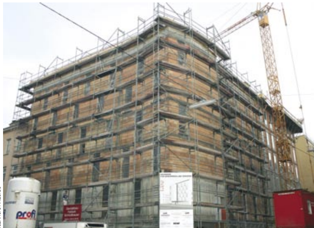
Das Seniorenwohnheim in Wien-Favoriten steht kurz vor der Fertigstellung.
