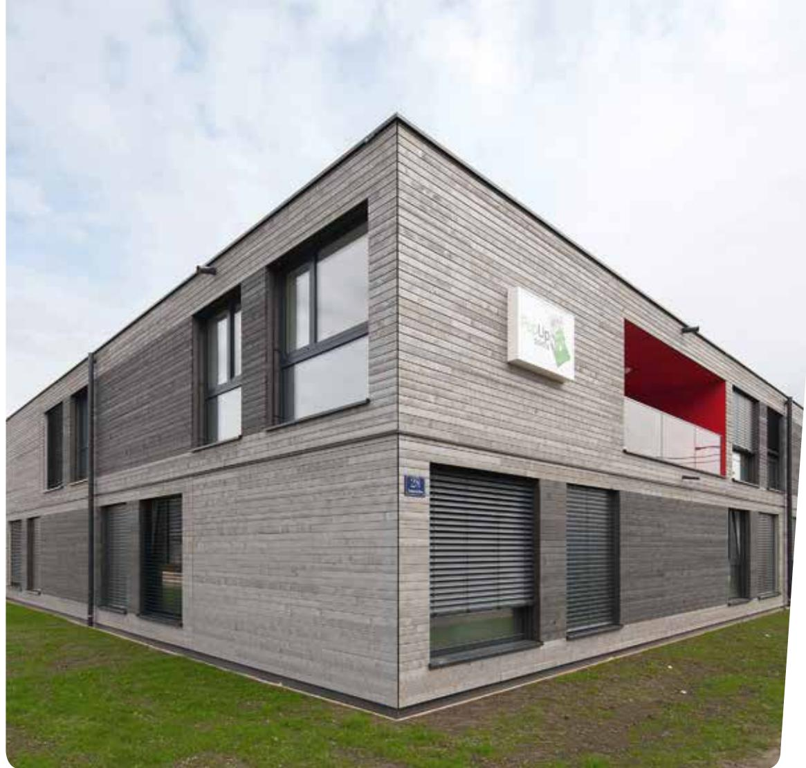
Ein Tarnkleid für die Kiste: Um die Bauweise aus vorgefertigten Holzmodulen zu kaschieren, wurden die PopUp dorms mit einer horizontalen Lärchenlattung verkleidet.
