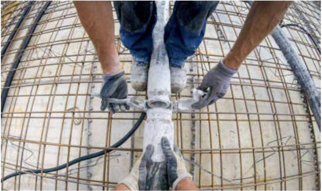
Endlich ist der Betonschlauch da. Pumpe einschalten. Und los. Wenn sich die graue Suppe über die mühsam miteinander verwebten Stahlmatten ergießt, dann verschwindet die tagelange Handarbeit für immer im nassen Zement.
