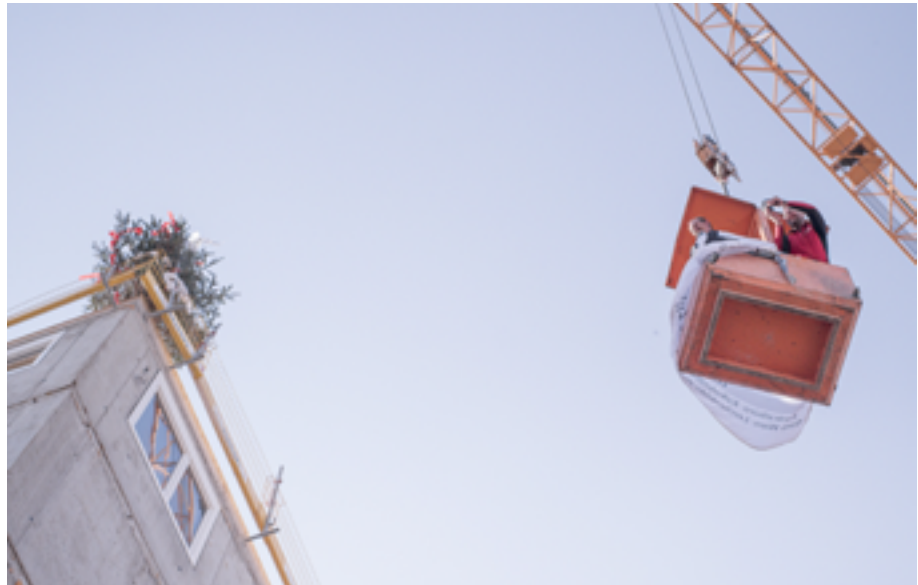
Ein Baustellenflug im Krankorb war die Gästattraktion bei der Dachgleichenfeier "Lebenscampus Wolfganggasse"
